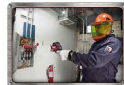
Диагностика предохранителей
